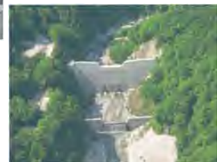
天竜川飯島第6砂防えん堤(不透過型)
