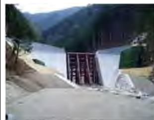
木曾川梨子沢第1砂防えん堤(透過型)
